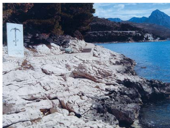
Slika 3 - Dječičanski izgled obale na ulazu podmorskog energetskeg i TK kabela u more u mjestu Drvenik ( priobalna zaštita izvedena strojnim bušenjem )
