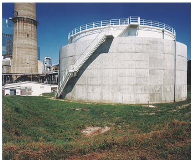
Slika 2. Spremnik ekstra lakog lož ulja sa zaštitnim zidom (TE-TO Zagreb)
