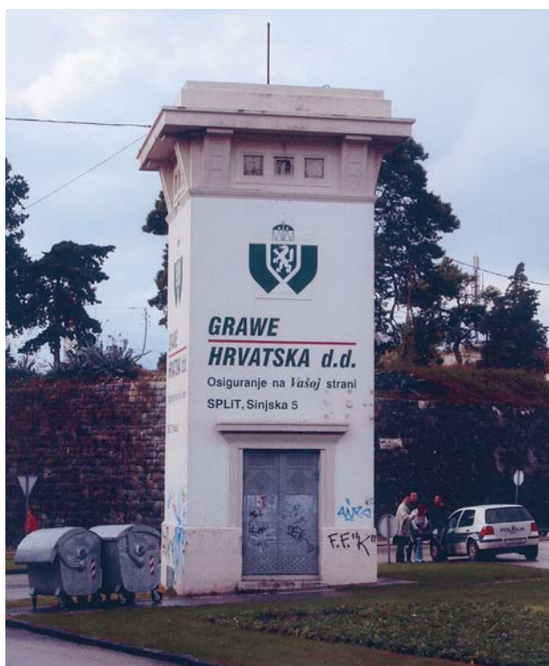
Slika 1. TTS 10/0,4 kV MANUŠ, izgrađena 1920. god.
