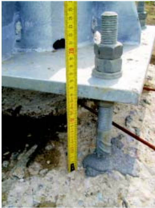
Slika 10. Princip regulacije montaže čelične konstrukcije na temelje
