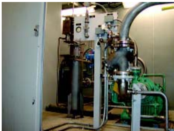
Slika 12. Održavanje pomoćnog sustava vode za injektiranje ako se radi s tekućim gorivom može biti itekako važno
