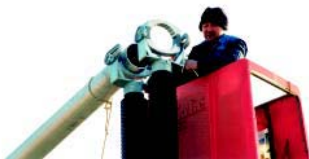
Slika 12. Slike sa montaže cijevnih sabirnica
