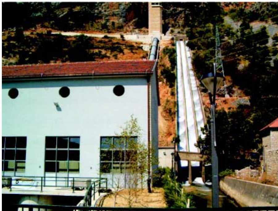
Pogled na strojarnicu, cjevovod, brzotok i vodnu komoru HE Peć Mlini
