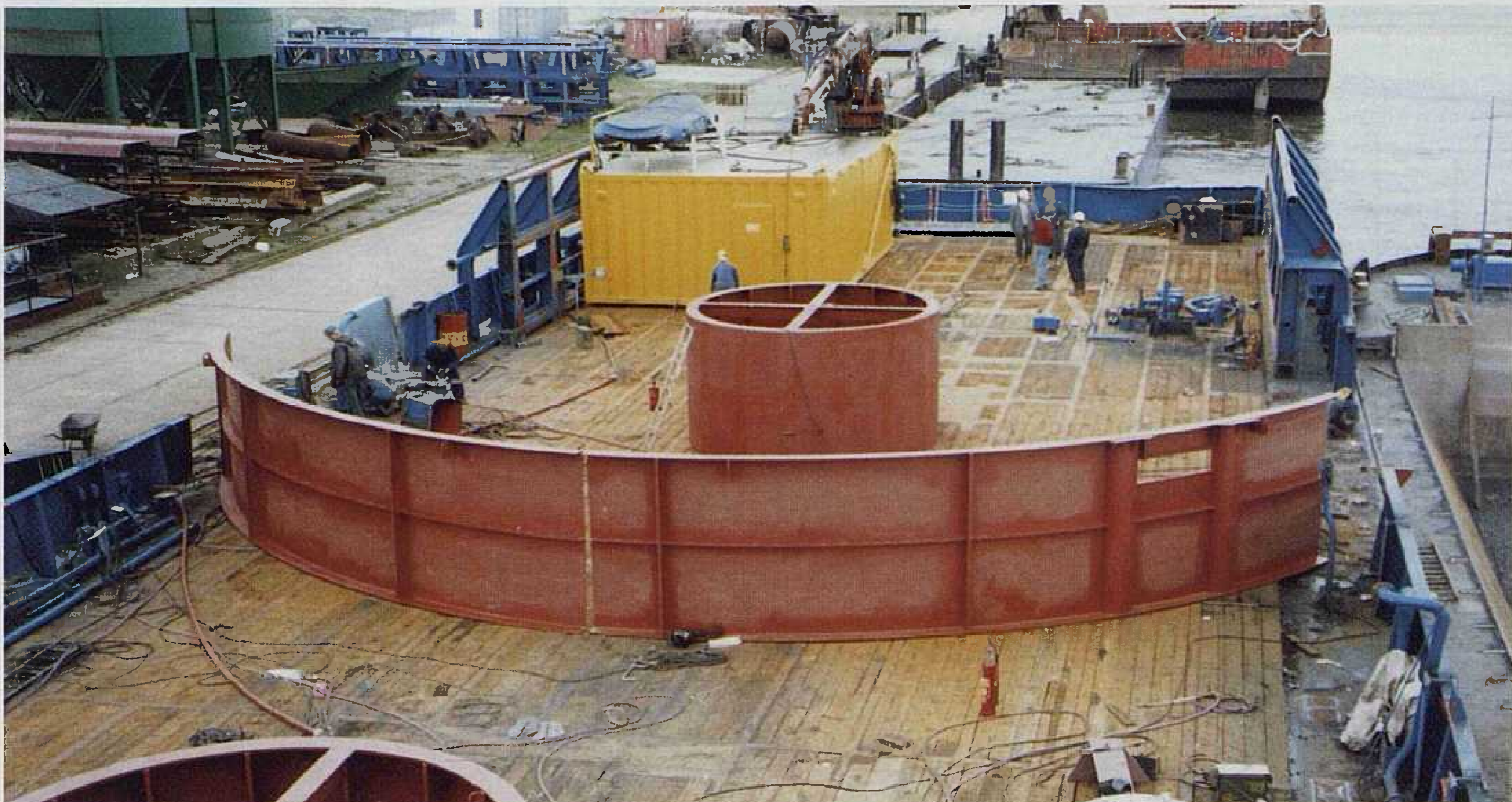
Slika 17. Brod "Cable Carrier" u rekonstrukciji
