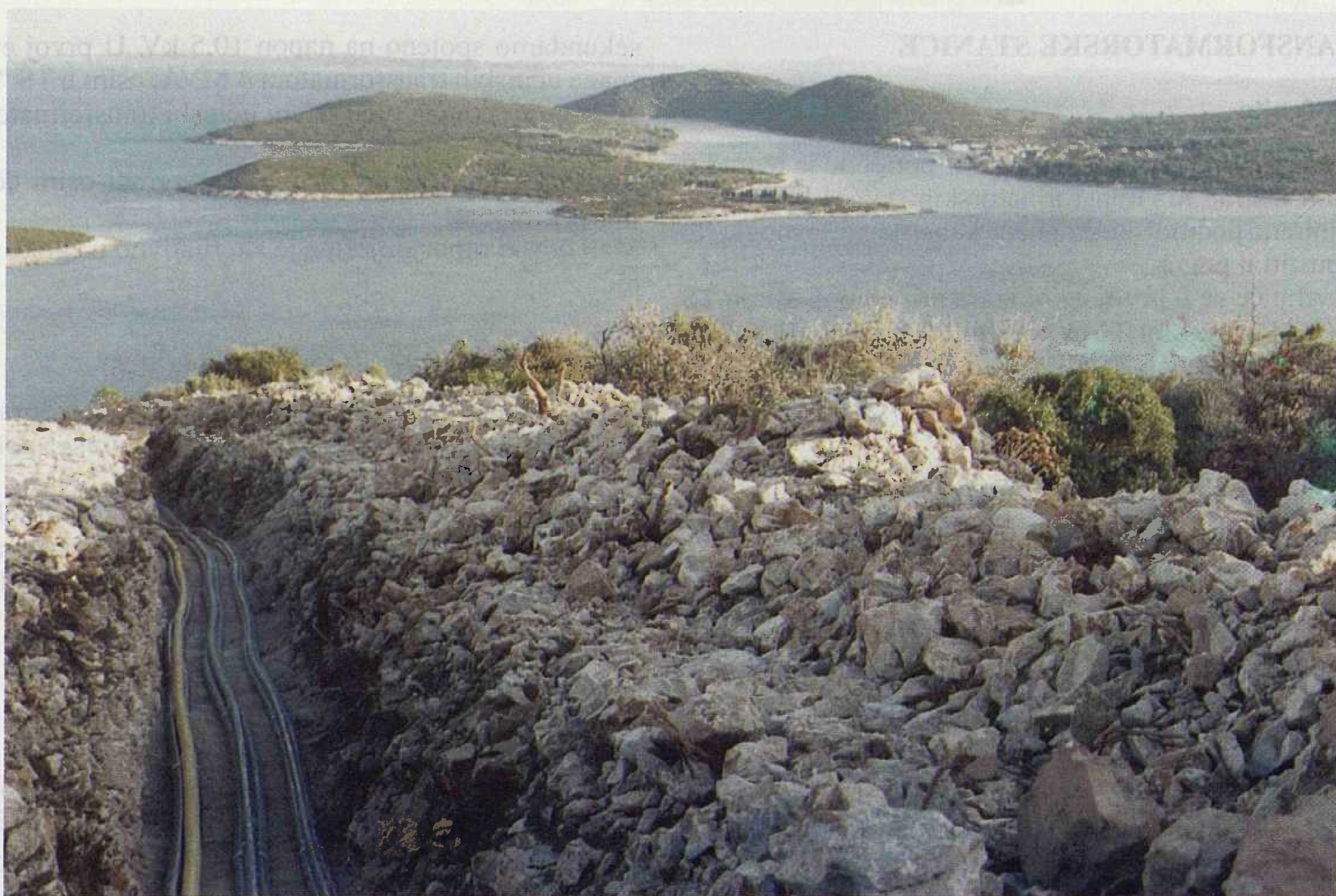
Slika 36. Polaganje kopnenog kabela na o. Lošinju
