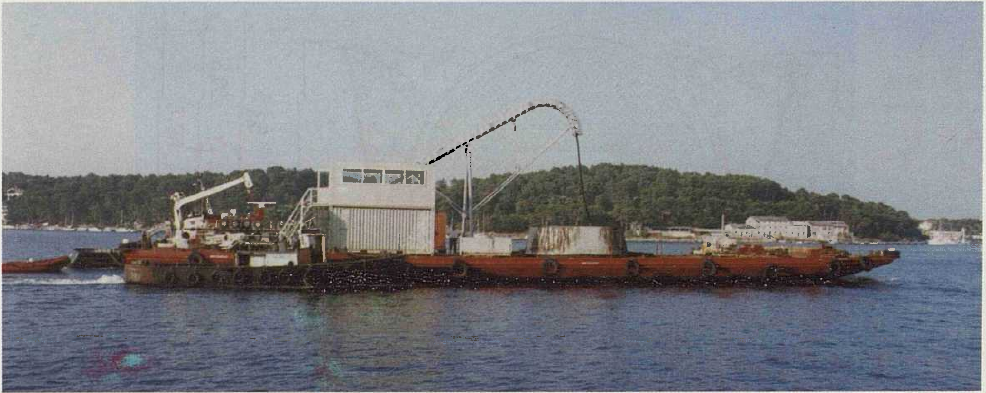
Slika 33. Barža "Lumbarda" polaže podmorski kabel o. Lošinj–o. Koludarcac
