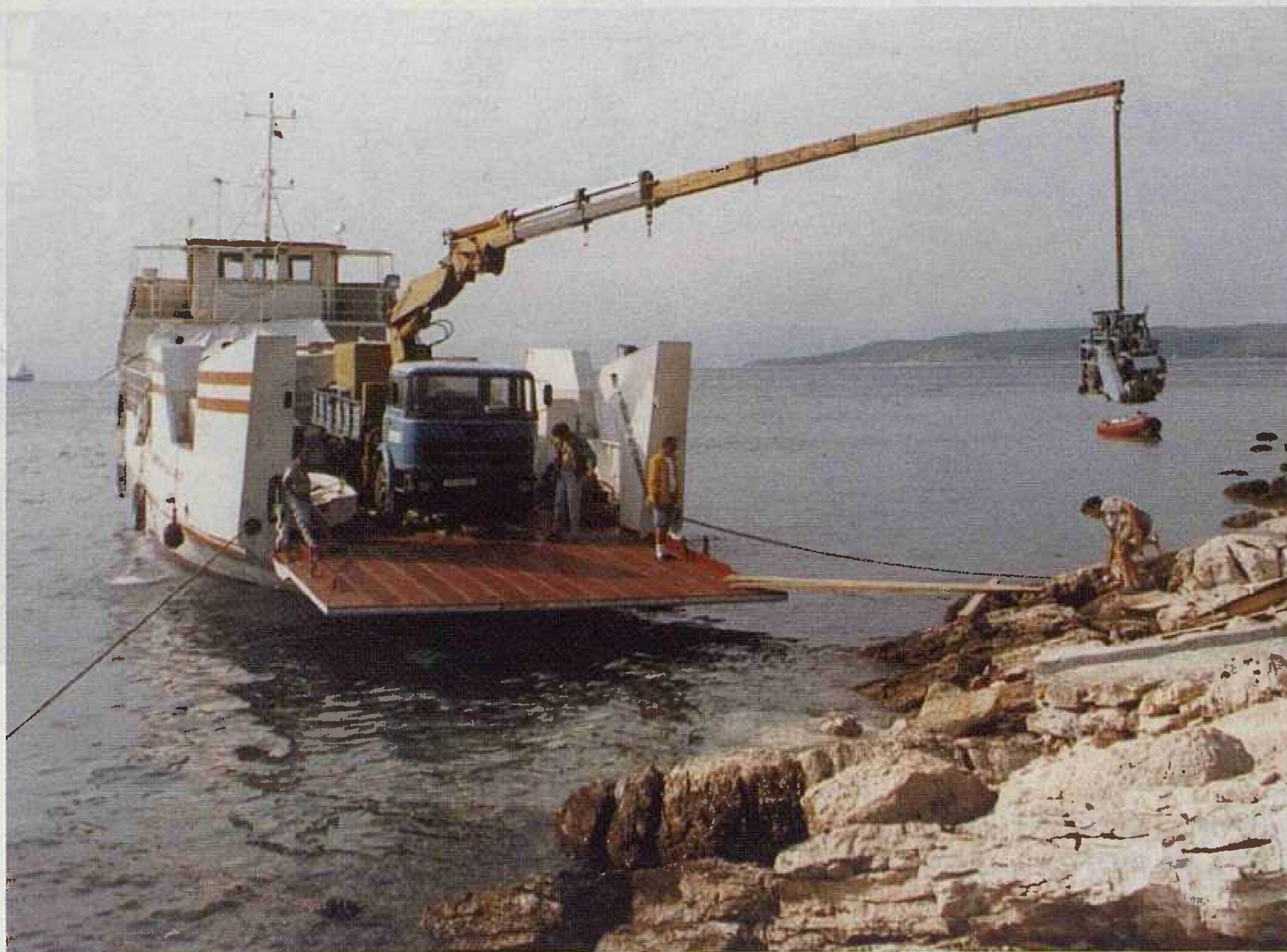
Slika 28. Trajekt "Nautika 64" – pretovar stroja za izvlačenje kabela
