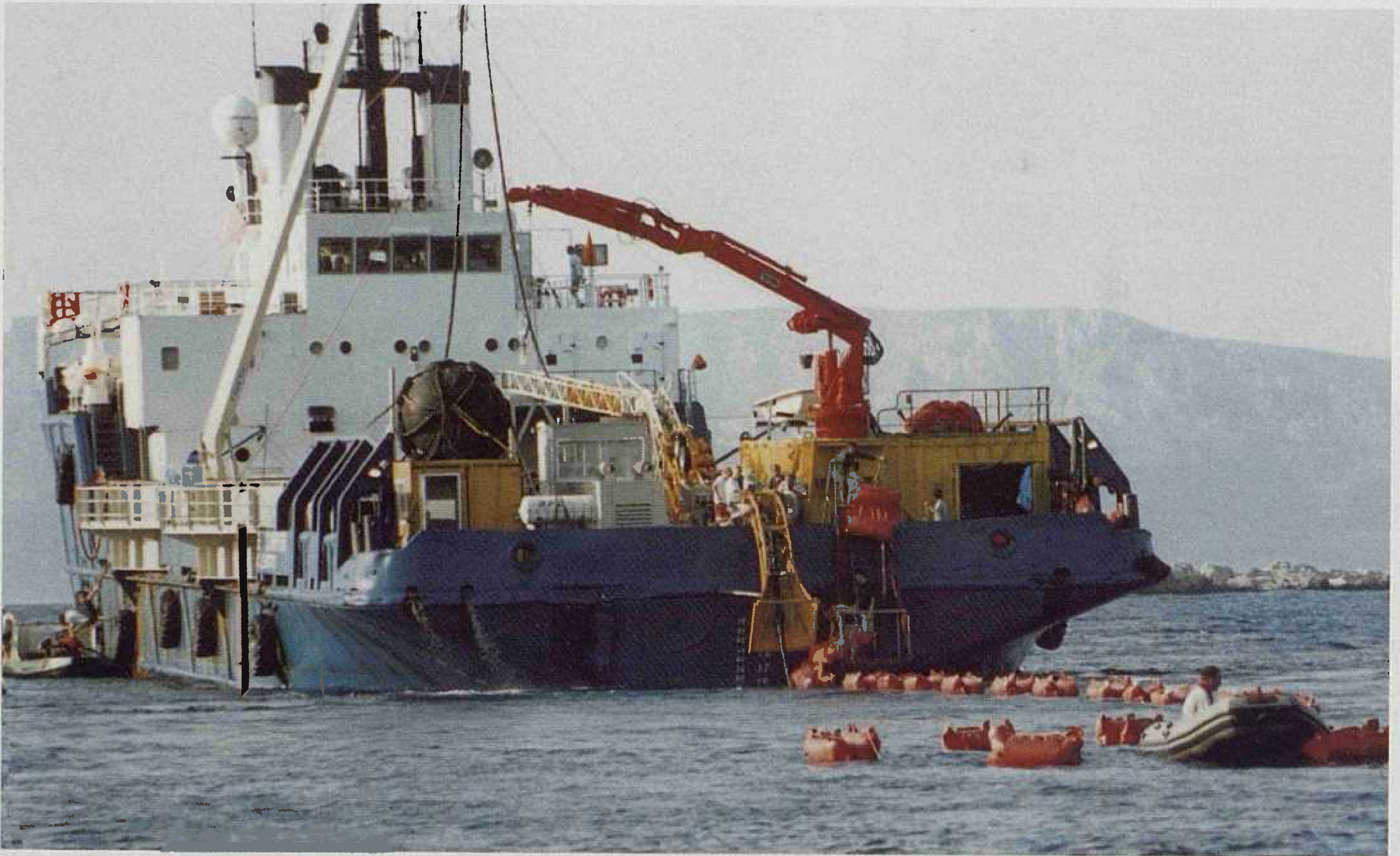
Slika 25. Kabel plovi prema obali
