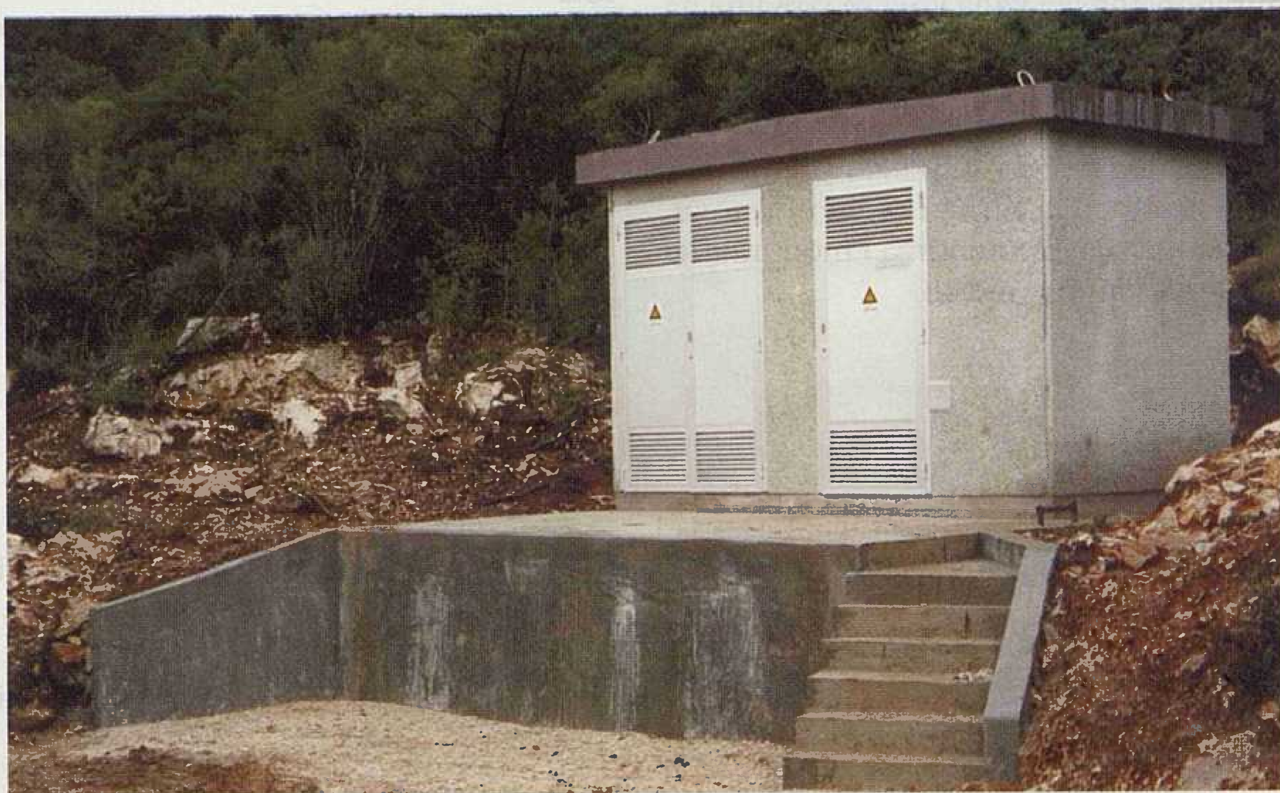
Slika 41. TS 10(20)/0,4 kV na o. Lastovu
