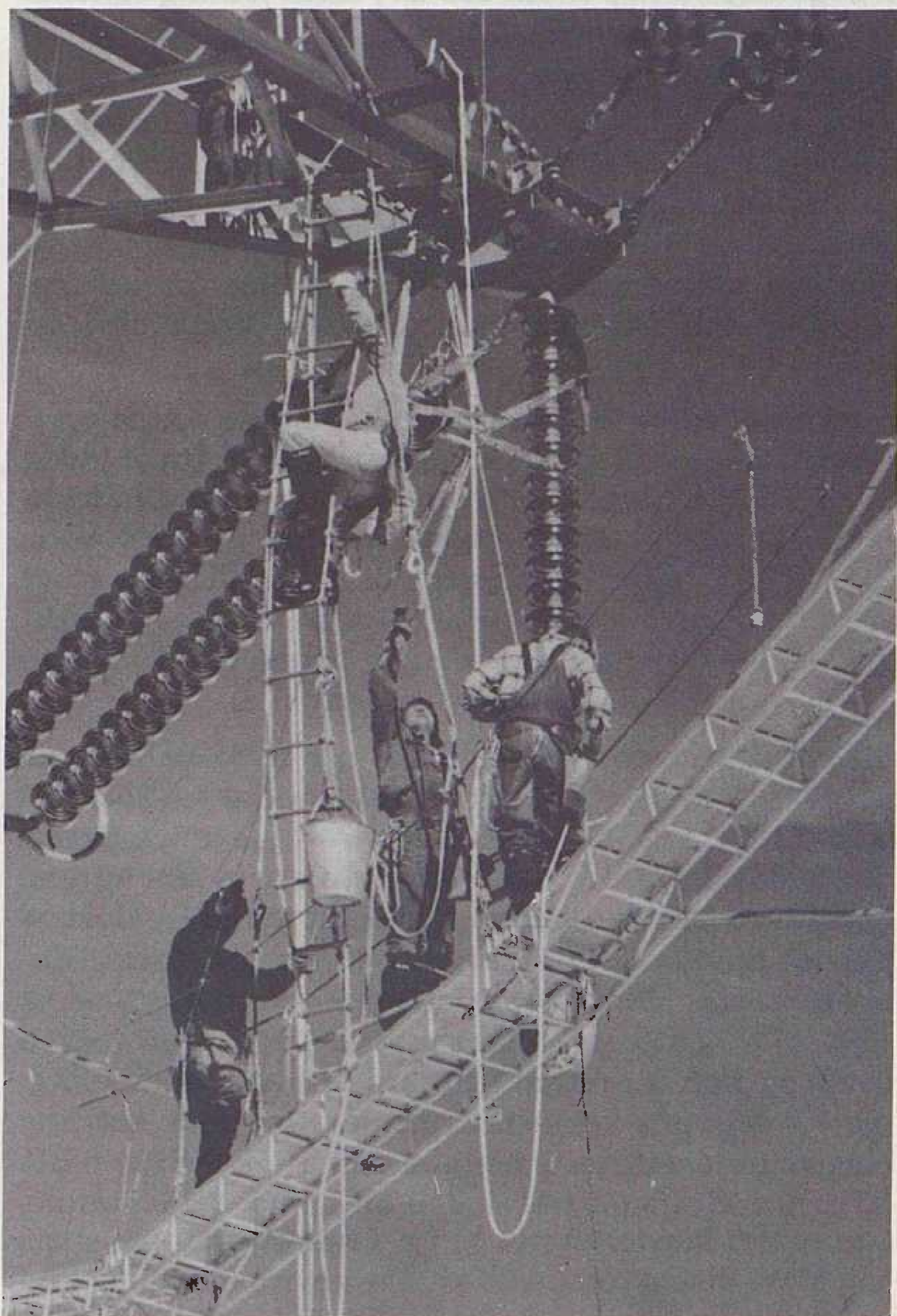
Slika 5. Montažni radovi na dalekovodu 2 \times 400 \text{ kV} Tauern – Lienz
