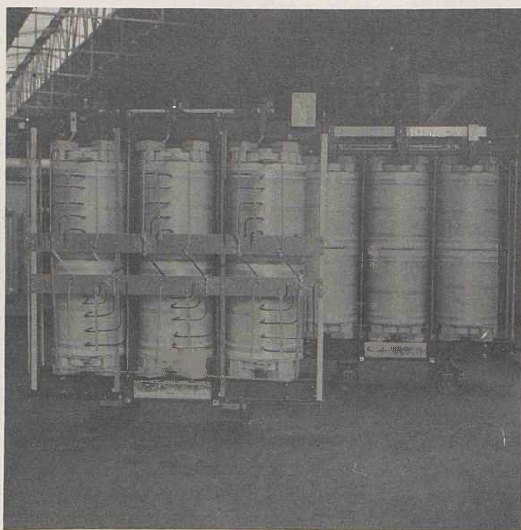
Suhi transformator, 630 kVA Termička klasa izolacije H
