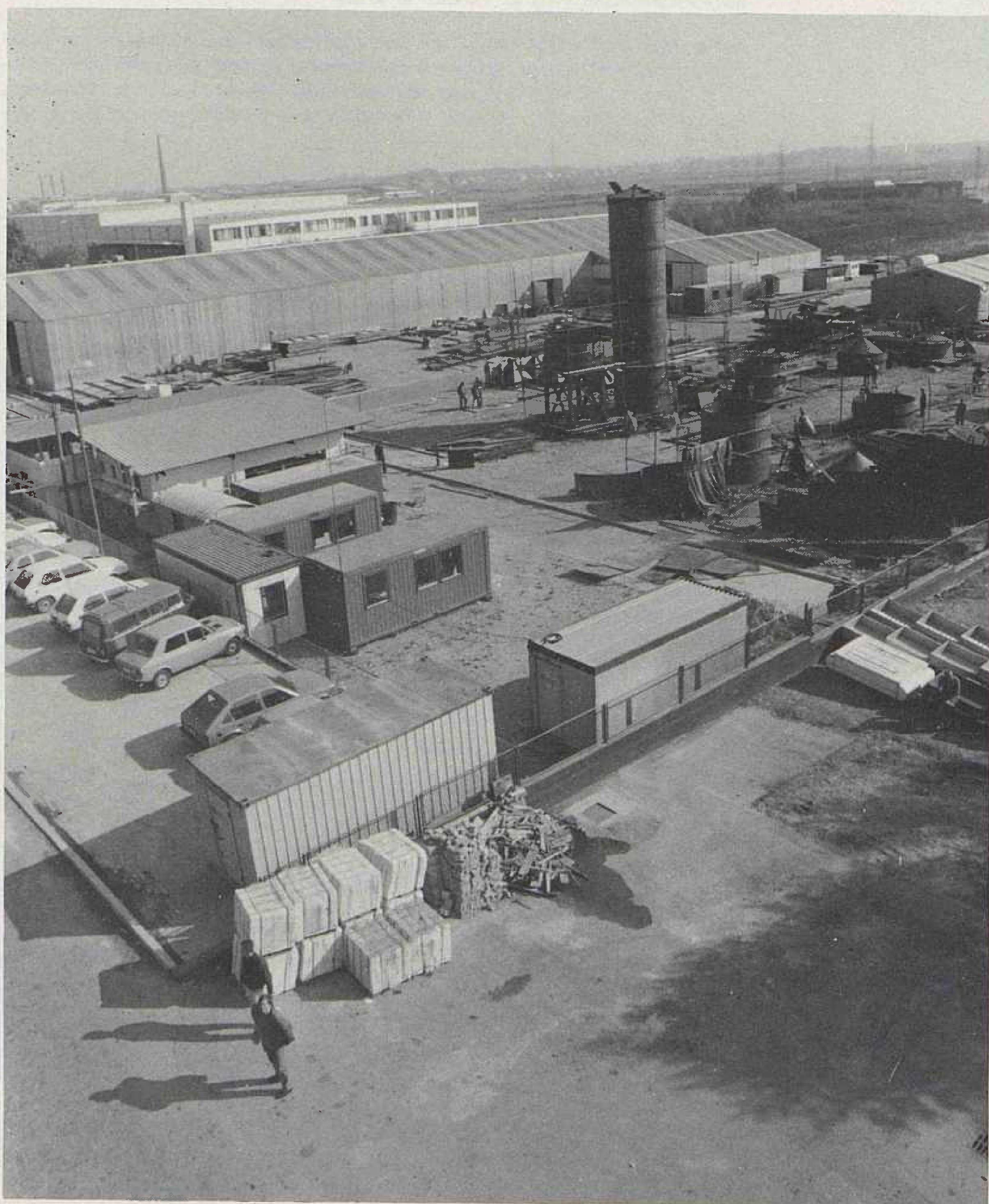
PROIZVODNI POGON U DUGOM SELU — PROIZVODNJA SILOSA I ČELIČNIH KONSTRUKCIJA
