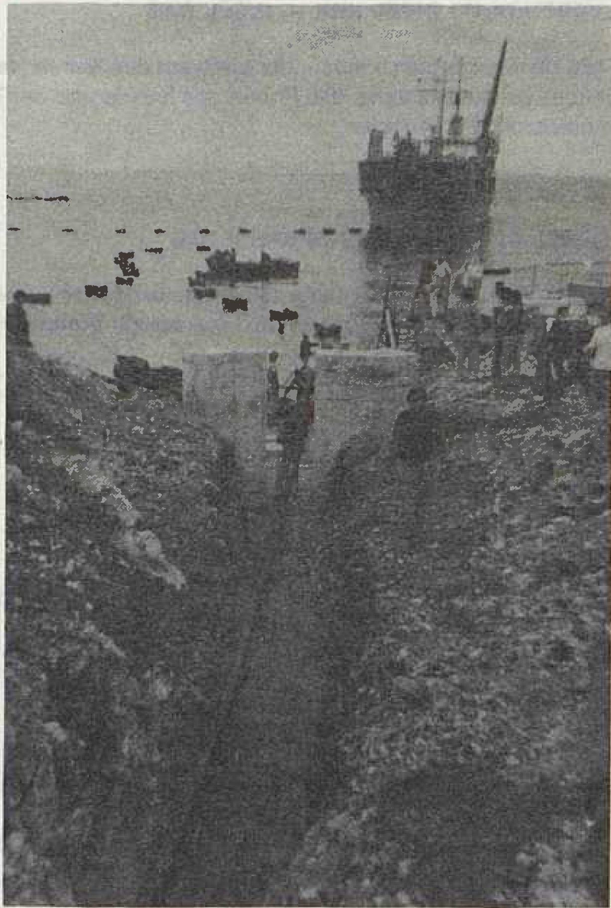
Slika 12. Izvlačenje kabela u uvali Surbova na otoku Krku
