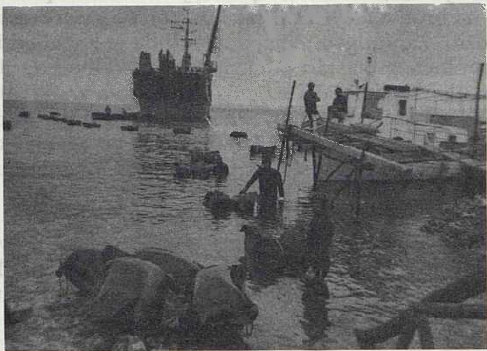
Slika 11. Detalj polaganja kabela
