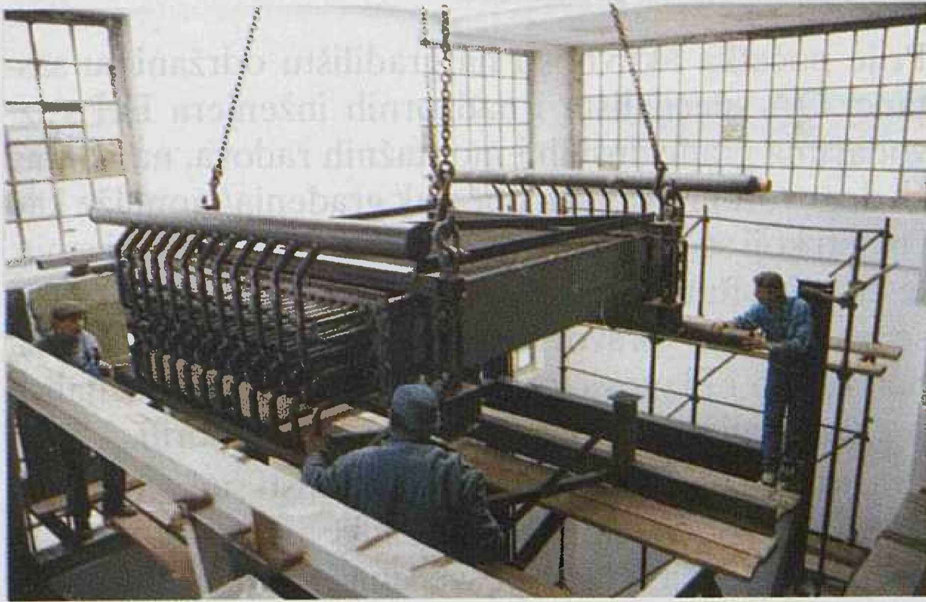
Slika 2. Montaža paketa kotla utilizatora
