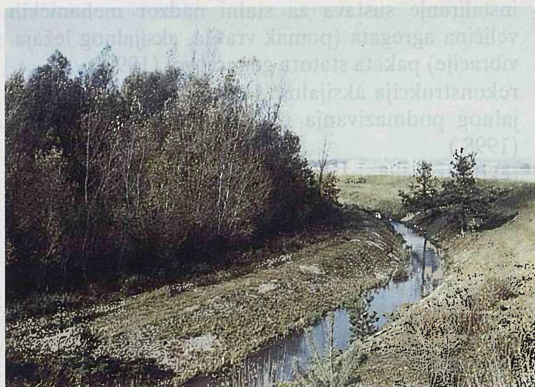
Slika 10. Pogled na desni nasip akumulacije HE Varaždin
