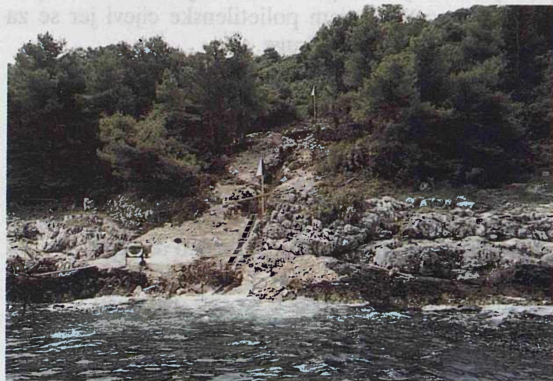
Slika 8. Priobalje na mjestu izgradnje priobalne zaštite
