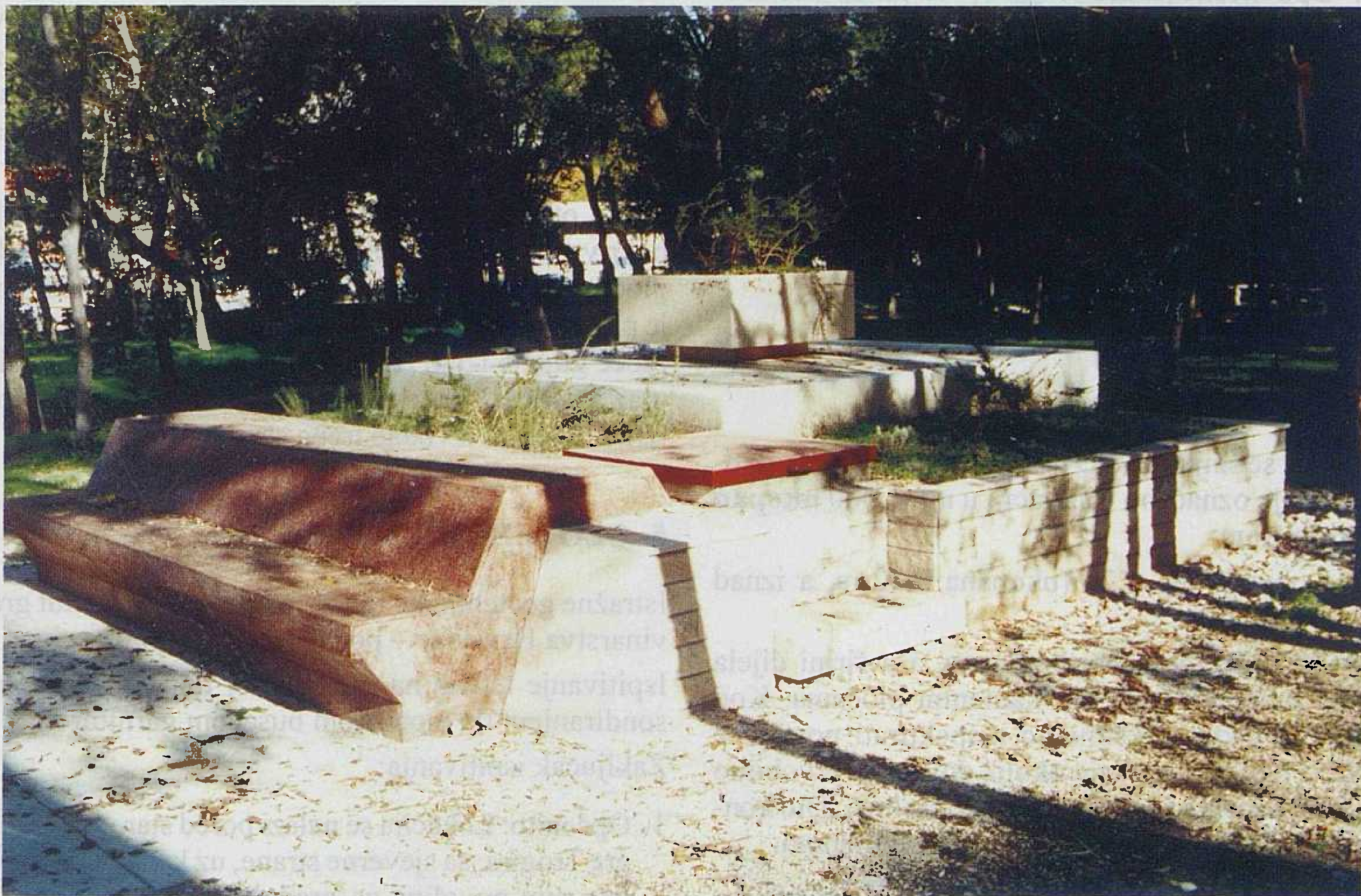
Slika 1. TS 10(20)/0,4 kV "Fortin" - fotografija izgrađene TS
