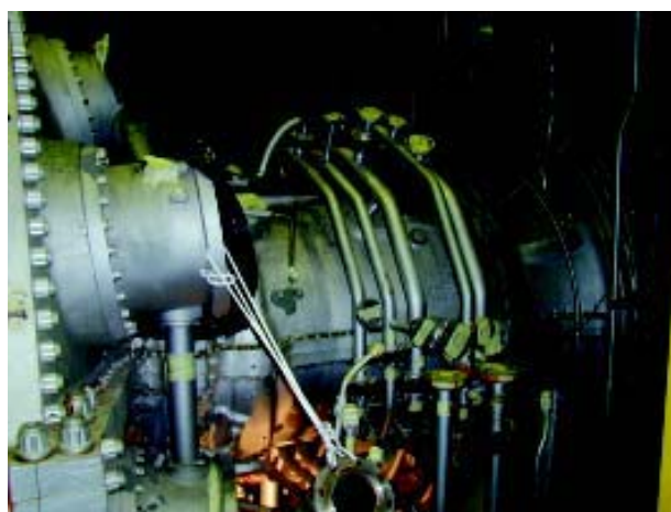
Slika 1. Rastavljanje turbine za pregled sustava izgaranja u TE-TO Zagreb na turbini MS6001FA
