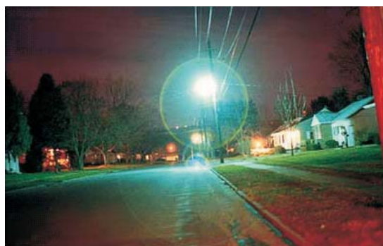
Slika 6 - Primjer blještanja kod loše cestovne rasvjete [Izvor: THORN – stručna dokumentacija, 2001.]
