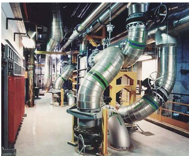
Slika 4. Baterija boca CO 2 generatora parne turbine nenametljivo uza zid pored ostale opreme
